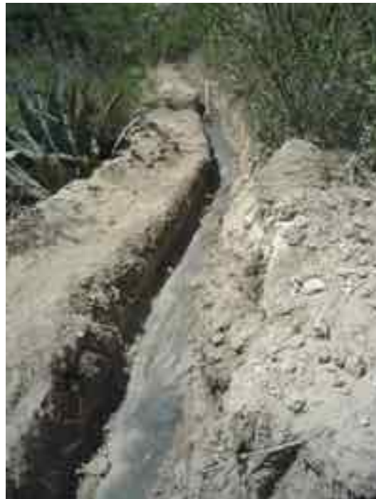
Zanja de infiltración
