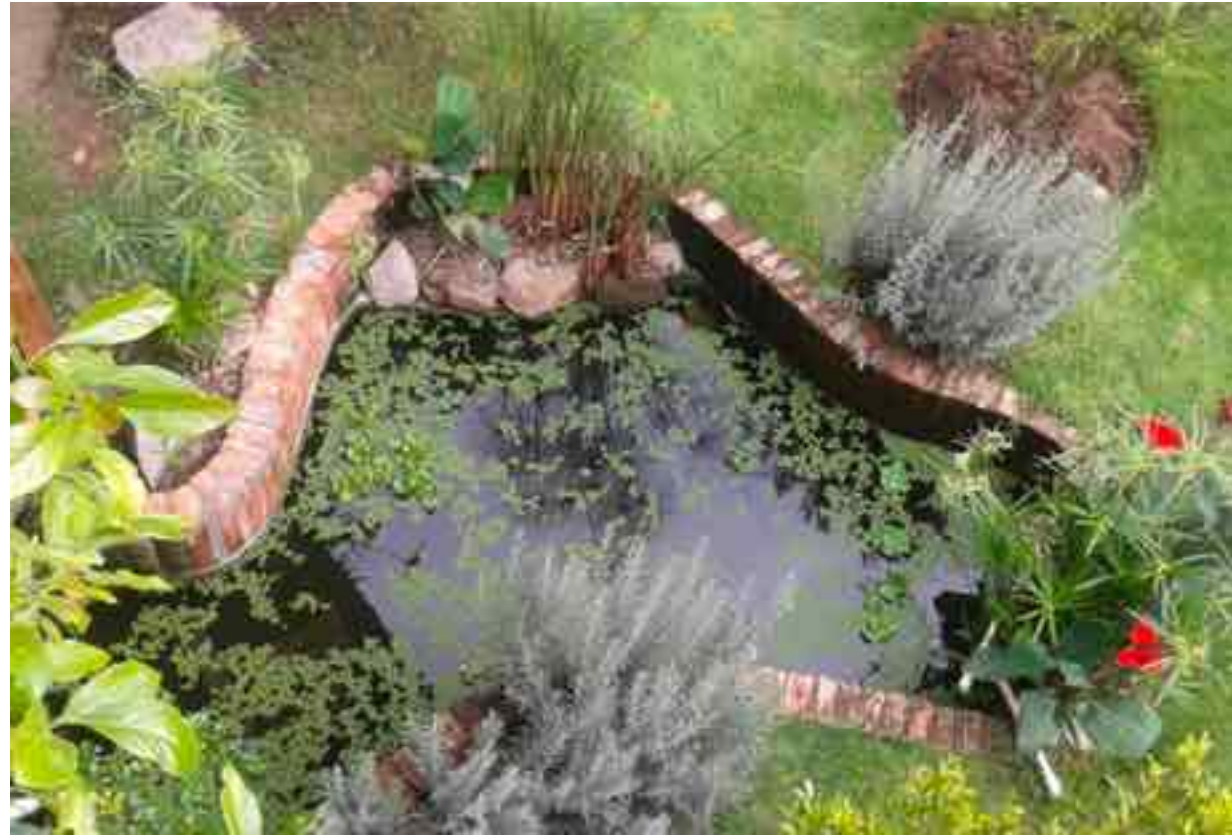
Laguna facultativa. Etapa final del tratamiento
