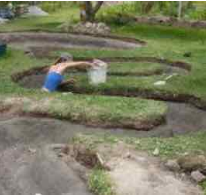
Camino sinuoso de ferro cemento para humedal
