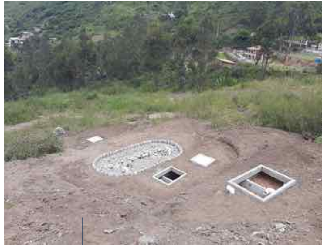
Vermifiltro y sustrato para humedal vertical
