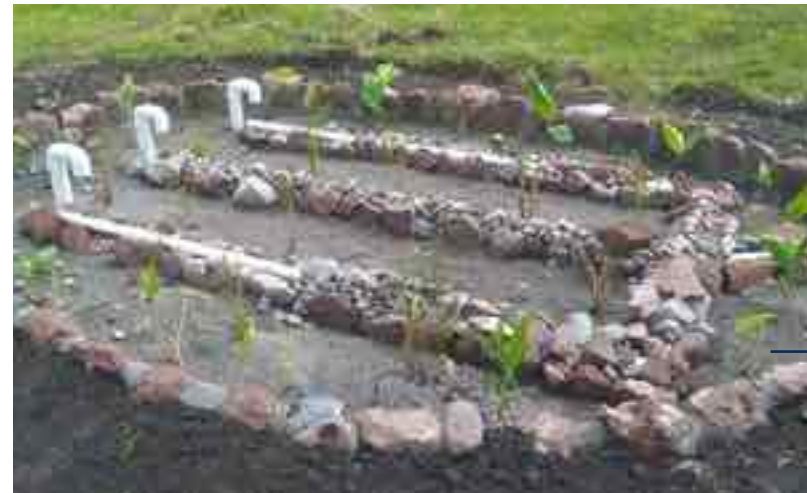
Pantano construido de flujo vertical subsuperficial con macrofitas biorremediadoras
